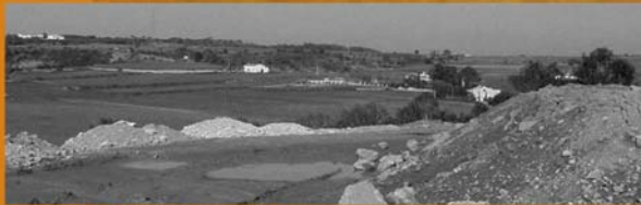
Parcel·la en fase d'excavació.
