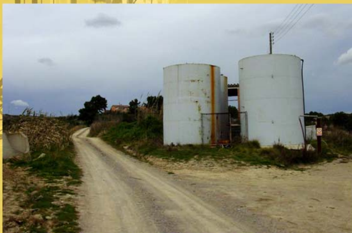
Les velles instal·lacions abandonades creen un fort impacte en el paisatge i cal preveure el seu enderroc si cessa l'activitat o han quedat obsoletes.
