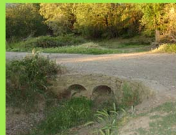
Sortida de tubs revestida amb pedres.
