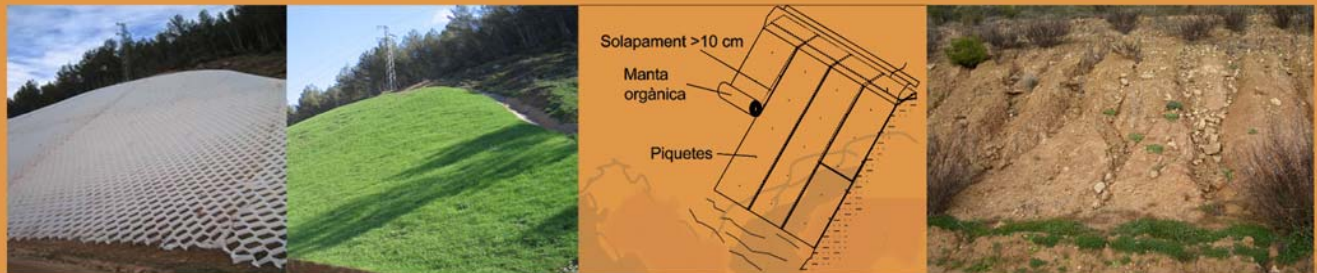
Talús tractat amb geocel·les: abans d'estendre la terra vegetal i un cop desenvolupada la capa herbàcia.
