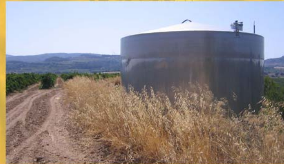
Nous requeriments han comportat noves instal·lacions en l'espai.
