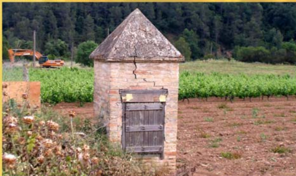
Algunes d'aquestes petites construccions caracteritzen el paisatge vitivinícola del Penedès i formen part del seu patrimoni arquitectònic.
