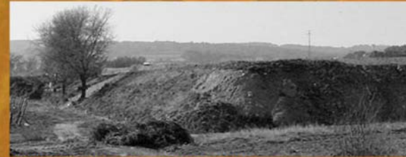
Formació de talussos en una esplanació.
