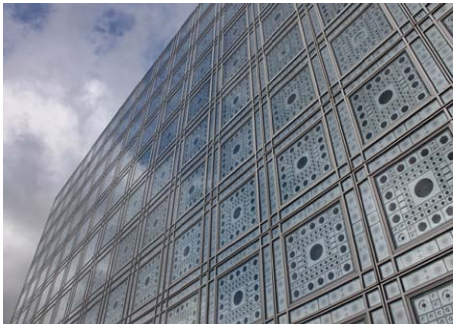
Imagen 4. En las últimas décadas, las fachadas se han hecho partícipes del paisaje de la ciudad, adaptándose a su entorno. El Institut du Monde Arabe, de Jean Nouvel, fue uno de los primeros edificios en utilizar las fachadas sensibles , que se comportan de forma diferente según el momento del día.
