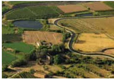
051_ Canal d'Urgell Canal de Urgell / The Urgell Canal / Canal d'Urgell Tornabous Jordi Bas
