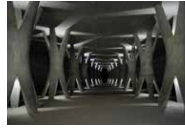
019_ Sala de les columnes de la presa de Susqueda / Sala de las columnas de la presa de Susqueda / Columns inside the Susqueda dam / Salle des colonnes du barrage de Susqueda Osor Albert Roura
