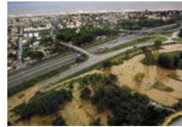
036_ Inundació Inundación / Flooding / Inondation Castelldefels David Airob
