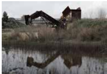
056_ Extracció d'àrids Extracción de áridos / Sand and gravel extraction / Extraction de granulat Montblanc Albert Carrera
