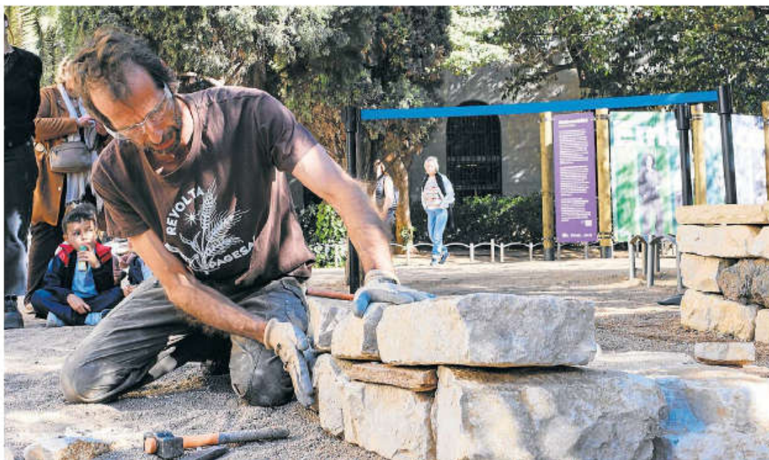
Demostració de la construcció d'un mur de pedra seca al jardí del Palau Robert per part del mestre marger Albert Gavaldà. FERRER/ARA
