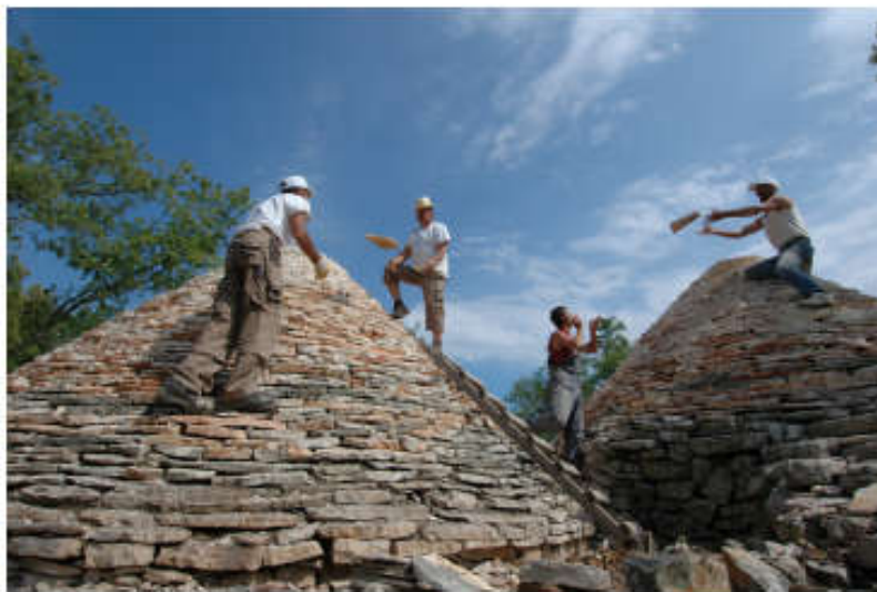
Canteros trabajando en construcciones de piedra seca
