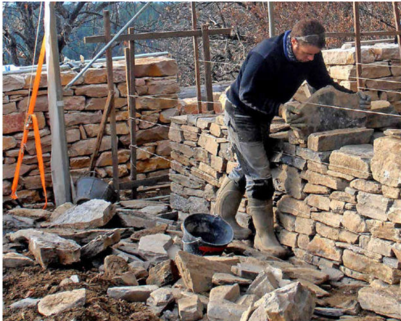
Roger Solé, marger d'Osona, treballant en un mur / LA FEIXA PEDRA SECA
