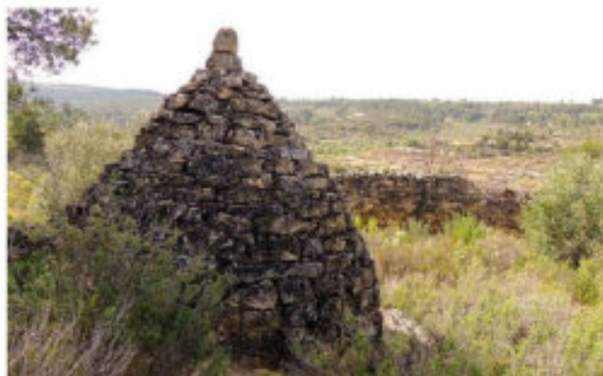
Un ajub, una de les construccions de pedra seca que es poden veure al terme de Torrebesses - CIPS (Centre d'interpretació de la Pedra Seca)
