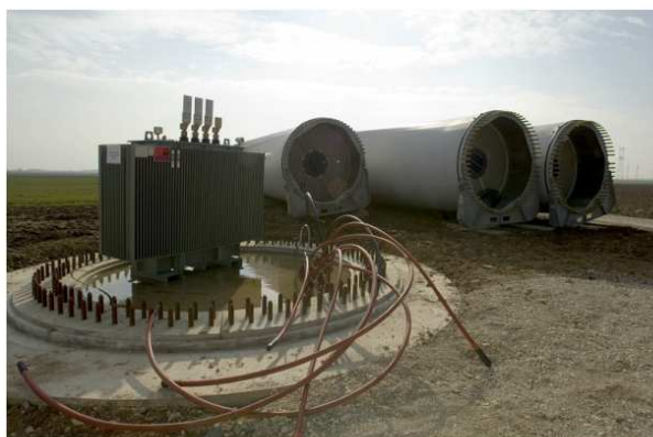
Chantier d'un parc éolien
