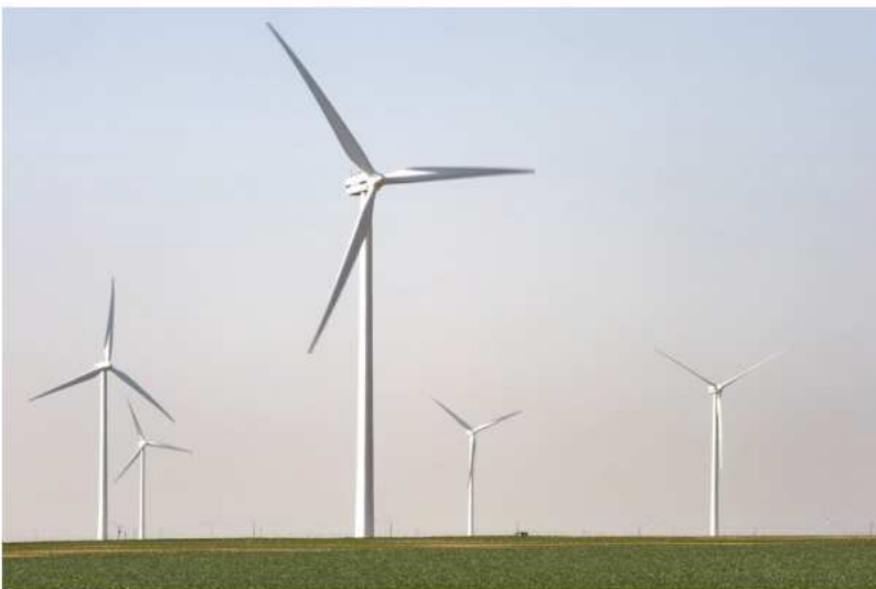
Parc éolien dans la Beauce
