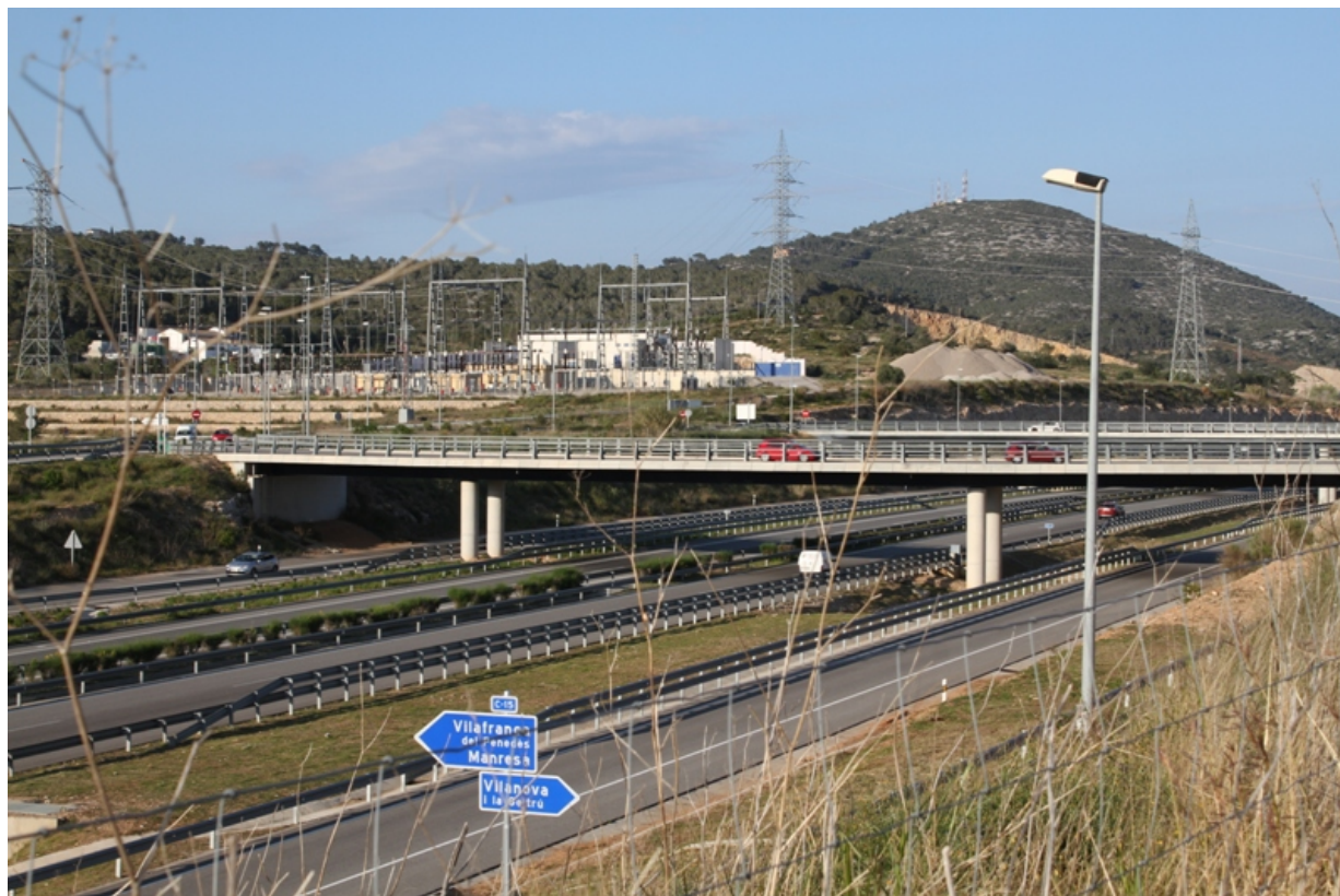
Foto. Forta transformació paisatgística a la zona d'enllaç entre la C-32 i la C-15, on a més es concentren també altres activitats de transcendència paisatgística com són transformadors elèctrics, línies de transport elèctric i activitats extractives.
