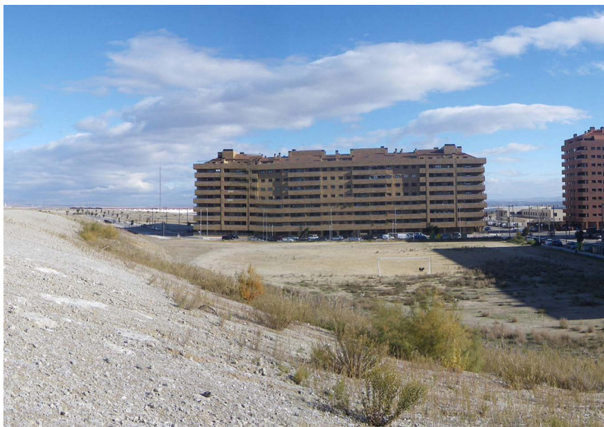
Imatge 5. Macroubanització de Seseña, envoltada d'un mar de terra erma.
