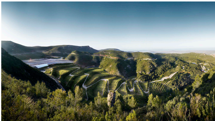
Imatge 3. La restauració paisatgística de l'antic abocador del Garraf buscava integrar el dipòsit controlat a l'àmbit del Parc Natural del Garraf. La intervenció de Batlle i Roig Arquitectura –Enric Batlle, Joan Roig, Teresa Galí-lzard ha merescut diversos premis.
