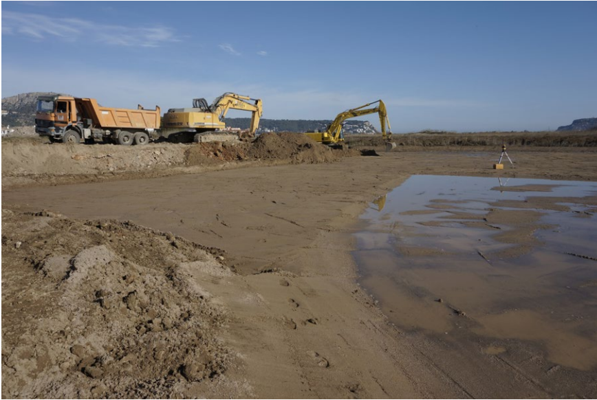
Imatge 2. Per crear les zones de maresma es va excavar fins a la cota prèvia a la urbanització de la zona.
