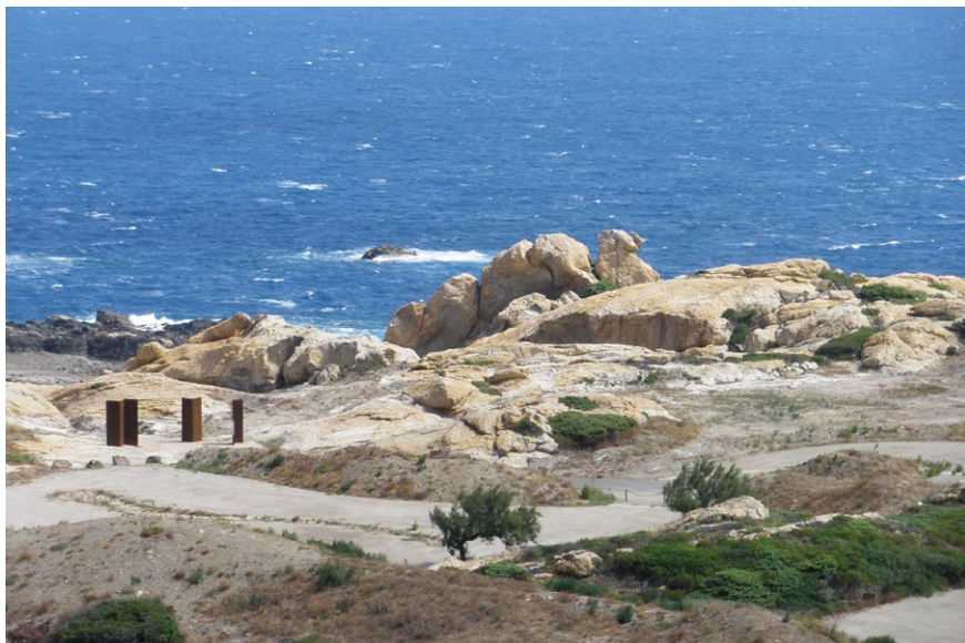
Imatge 2. Al paratge de Tudela, entre 2007 i 2010 es va portar a terme un procés de restauració que va consistir en la deconstrucció dels edificis de la ciutat de vacances i la retirada de les plantes invasores.
