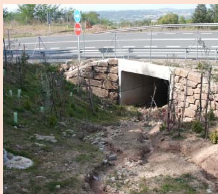
Imatge 4. Obra de fàbrica sota una carretera per al pas de fauna.
