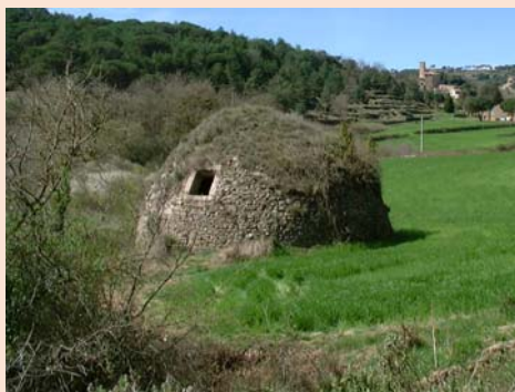
Imatge 1. Caseta de pedra seca a conservar.
