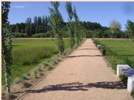
Imatge 3. Vials amb sub-base natural
