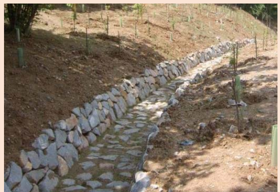
Imatge 2. Vista d'una cuneta amb revestiment de pedra d'escullera petita revegetable.
