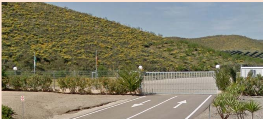
Imatge 1. Il·luminació exterior d'un PSF, en tot el recinte d'entrada, resseguint la tanca (a evitar), i amb làmpades rodones (no permeses).
