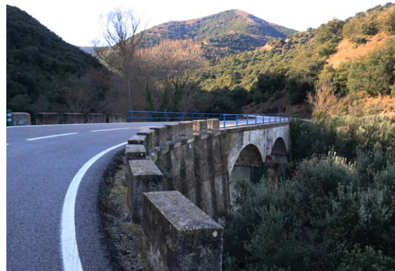
Fig.104 Poc abans d'arribar a l'àrea de lleure de la Font de la Teula per la carretera T-700, un pont permet salvar el Barranc del Tillar.
