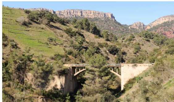
Fig.73 La carretera T-732 entre el Molar i el Lloar ha de creuar nombrosos barrancs, com el del Trenc, que permeten unes vistes espectaculars de la serra de la Figuera i els cingles.
