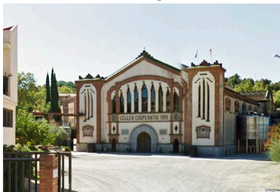
Fig.89 La Cooperativa de Falset és un edifici modernista amb un gran valor estètic i històric.
