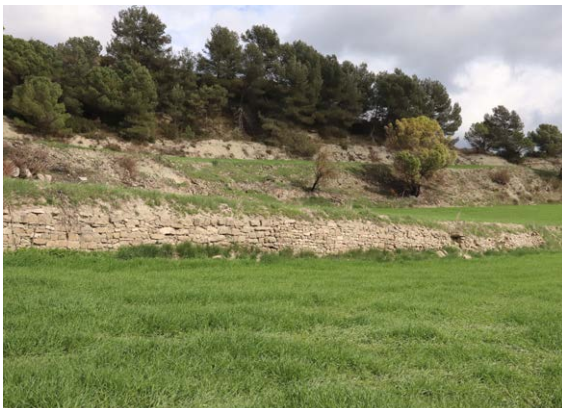
Fig.118 Prop de Santa Coloma de Queralt es conserven diverses terrasses delimitades per murs de pedra seca.
