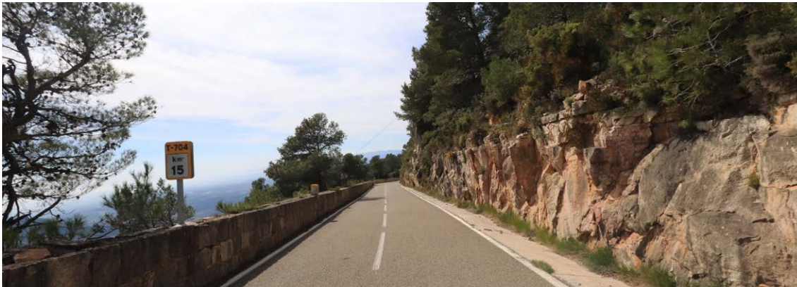
Fig.95 La carretera T-704, en ple descens cap a Vilaplana, encara conserva alguns elements de contenció, com els murs de pedra, de la construcció original.
