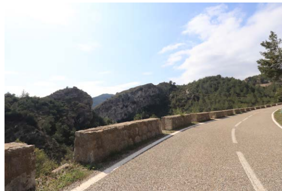
Fig.81 La carretera TV-3111 salva nombrosos desnivells al travessar la Serra de Llaberia, un espai singular i complex geològicament.
