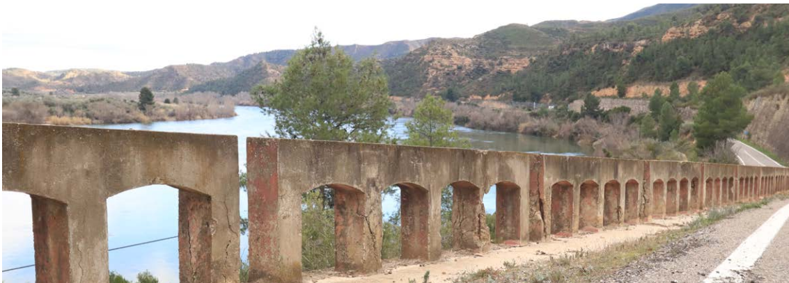
Fig.28 El meandre de los Senals, un cop passat l'embassament de Riba-roja. La presa i les construccions associades són ben visibles en aquesta part de la carretera.
