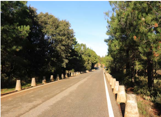
Fig.103 La pròpia carretera T-700 conserva diversos elements de valor històric i visual, com les pilones i murs que la delimiten en alguns trams.
