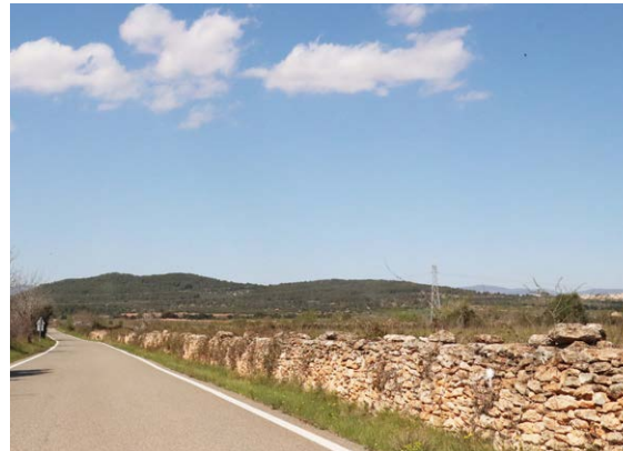
Fig.137 Prop del nucli de Bonastre, la carretera està delimitada en diversos trams per murs de pedra seca.
