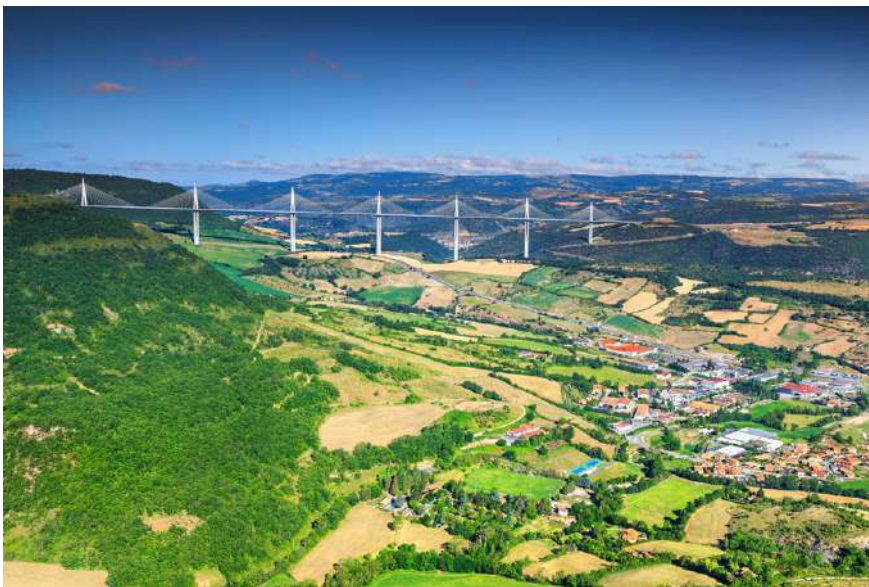
Imatge 3. El viaducte de Millau a través de la vall del Tarn és una obra mestra de l'arquitecte Norman Foster i de l'enginyer Michel Virlogeux. El disseny del tauler proporciona als automobilistes una perspectiva espectacular del pont, de manera que en poden veure els set pilars d'un cop d'ull.
