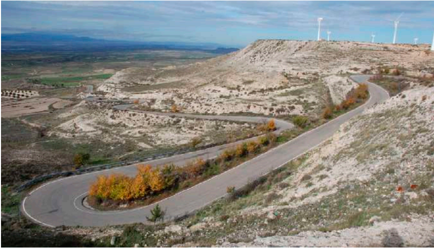
Imatges 2. Exemple de traçat en ziga-zaga que permetia atemperar els pendents longitudinals.
