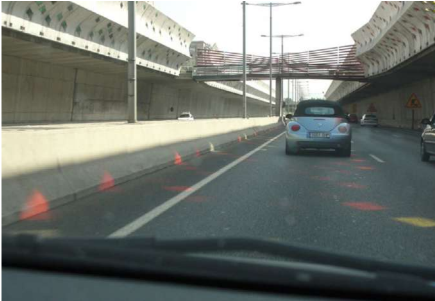
Imatge 5. Efectes lumínics dels panells acústics col·locats al llarg de la Gran Via de les Corts Catalanes, la C-32.
