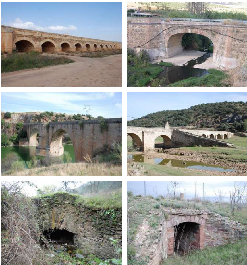
Imatges 9 a 14. Exemples d'estructures i obres de drenatge de les carreteres històriques.
