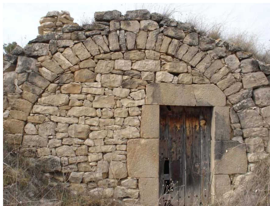
Figura 8.15. Detall de la forma de construcció d'una cabana de volta (foto: O. Cornudella)
