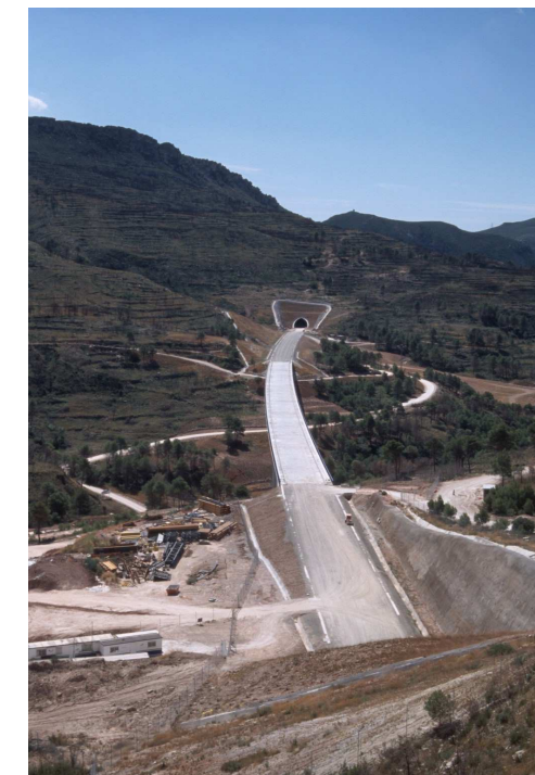
Figura 4.7. Efectes sobre el paisatge de la construcció de la plataforma per al Tren de Gran Velocitat, a partir de túnels i viaductes, en el tram de Vilaverd, al sud de la unitat.
