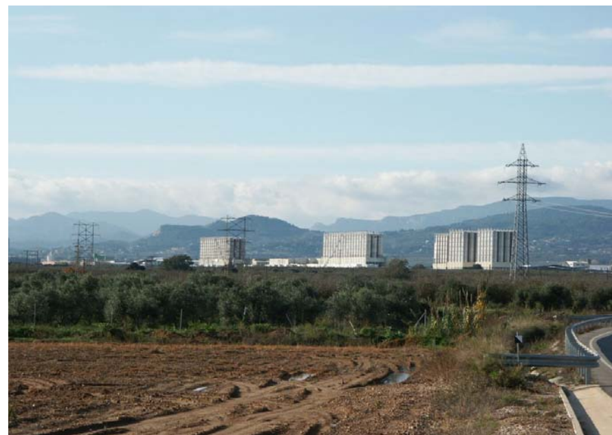
Figura 21.7. Grups de sitges i torres elèctriques que modifiquen el caràcter agrícola del paisatge i trenquen la monotonia i la horitzontalitat de la plana.
