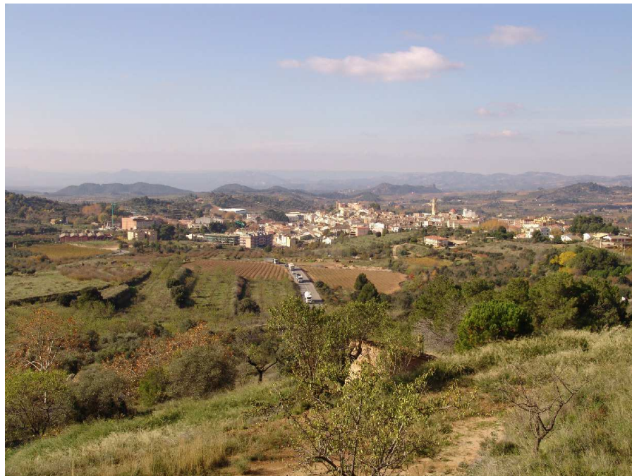
Figura 12.5. El poble de Falset és el nucli més dinàmic del Baix Priorat. La implantació d'edificis i polígons de diferent tipologia i aspecte pot alterar el paisatge periurbà i fer disminuir la qualitat general del paisatge, una de les bases del seu creixement urbanístic recent.
