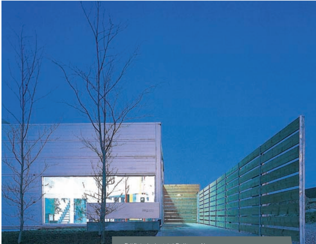
Edificio Industrial Rolltore, Navarra. Carlos Urzainqui, Fernando Oiza y Eduardo Urdián.
