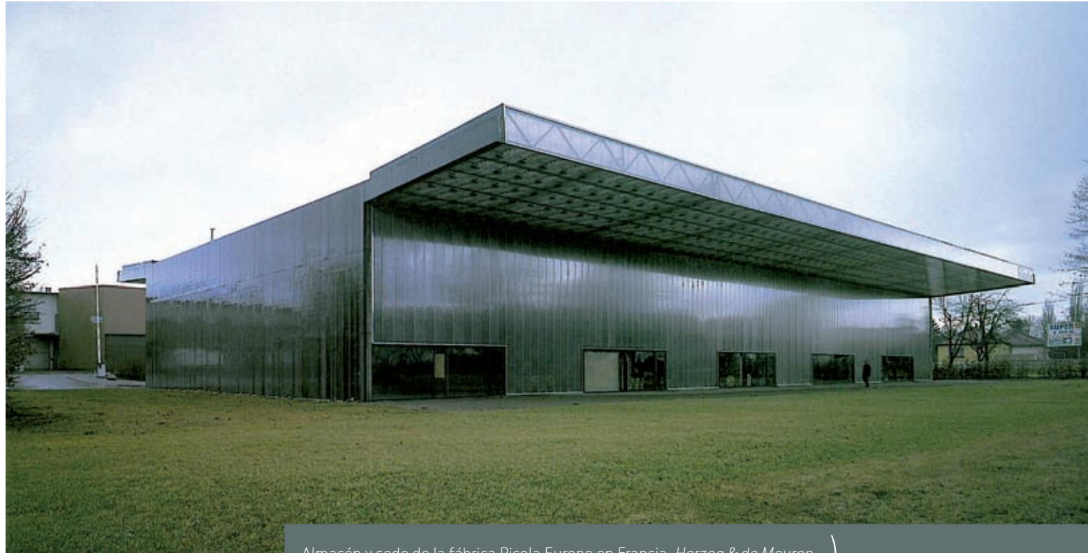
Almacén y sede de la fábrica Ricola Europe en Francia. Herzog & de Meuron. )
