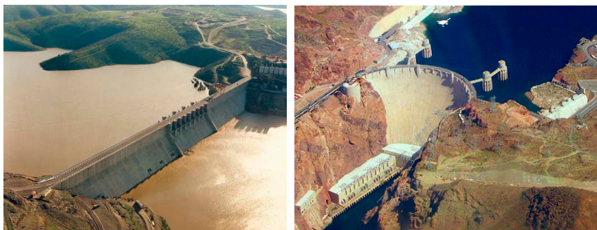
Imatges 4 i 5. El tipus de presa condiona enormement la seva percepció. A la dreta presa de gravetat del pantà de Serena a Badajoz i a l'esquerra la presa d'arc de Hoover.
