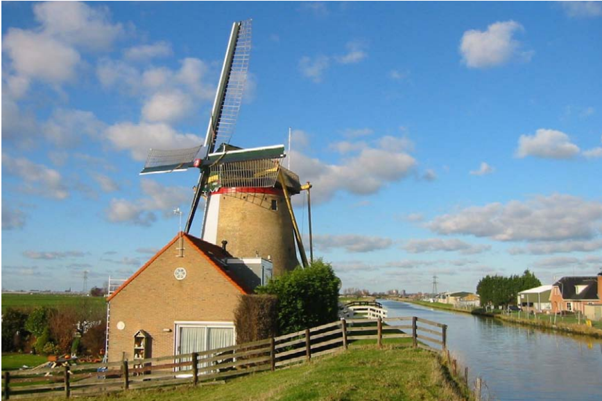
Imatge 1. Als Països Baixos els molins de vent s'utilitzaven històricament sobretot per drenar aigua de les terres situades sota el nivell del mar i poder-les cultivar. A la imatge, molí de vent a Schijpluiden, dins el municipi de Midden-Delfland.
