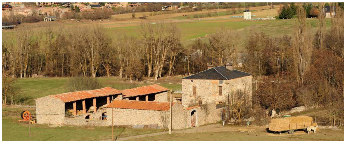
El mas cerdà, construcció tradicional d'explotació agropecuària La ferme cerdane, bâtiment traditionnel d'exploitation agropastorale
