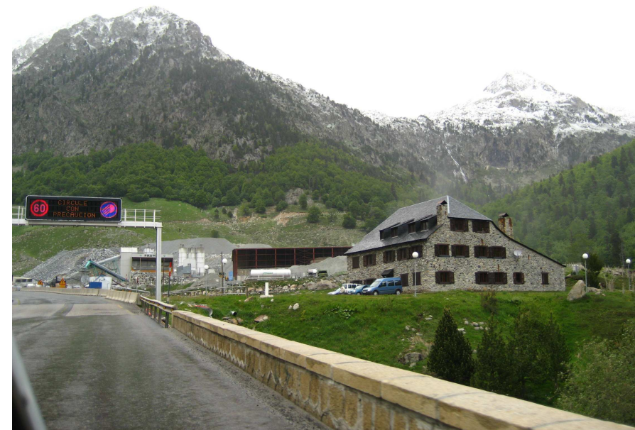
Figura 7.38: La demanda de noves i més ràpides carreteres té una especial incidència a la vall de Barravés, on s'ha construït el nou túnel de Vielha
