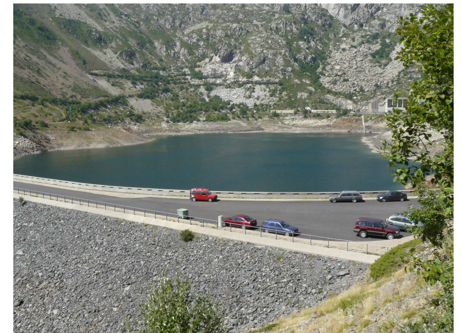
Figura 7.40: Els impactes derivats de l'aprofitament hidroelèctric dels rius de la zona són uns dels que han deixat més empremta sobre el territori, com és el cas de la presa de Sallente
