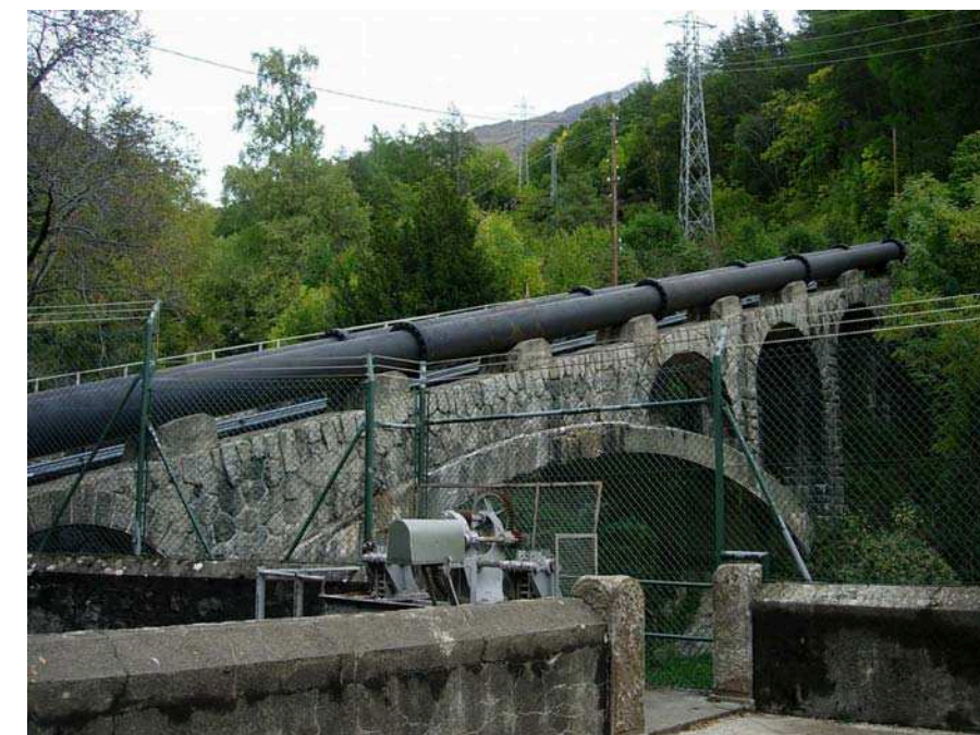
Figura 7.14: Canonada de pressió de la Central Hidroelèctrica de Cabdella. El conjunt arquitectònic de la central s'ha convertit en un element de fort arrelament en el propi paisatge de la vall Fosca
