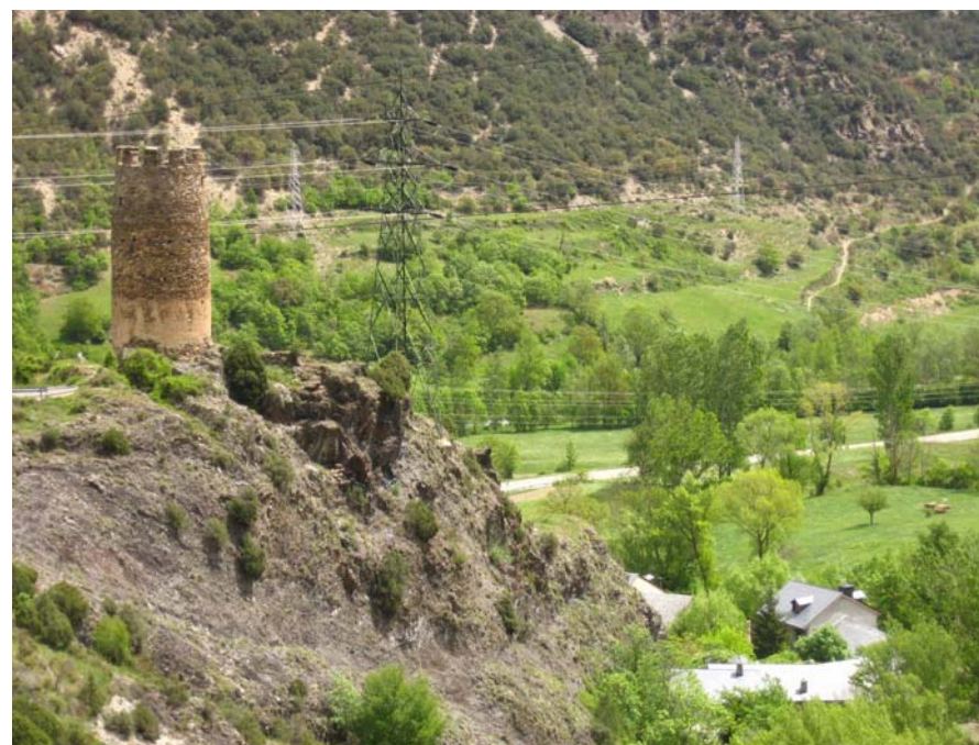
Figura 5.11: La torre de defensa que domina, des de dalt d'un espadat rocós, el poble d'Escaló, a la confluència entre la Noguera Pallaresa i la vall d'Escart, és una important fita en el paisatge
