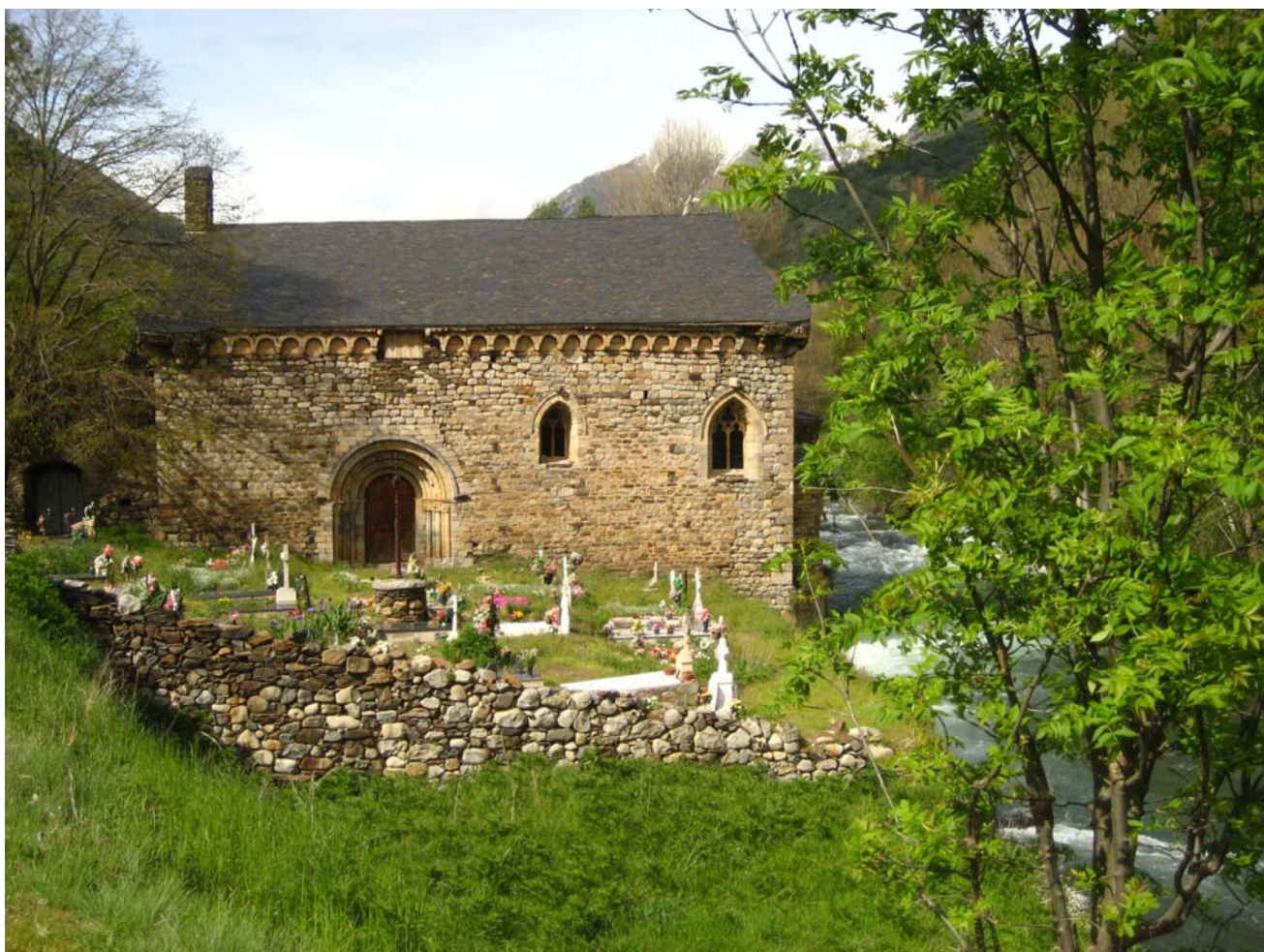
Figura 5.4: L'església romànica de Sant Joan d'Isil és una veritable joia arquitectònica enmig d'un paratge fluvial encisador
