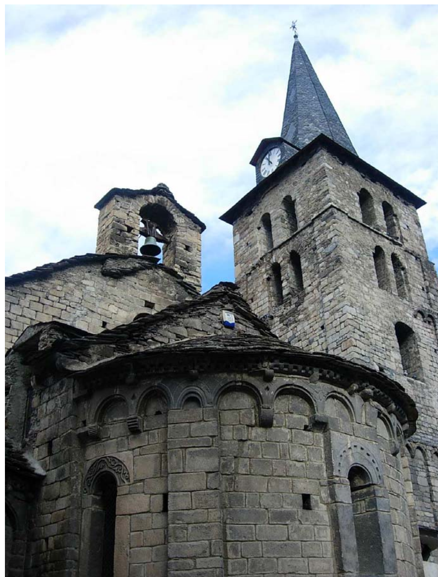
Figura 1.23: Església romànica dera Purificacion de Maria de Bossòst
