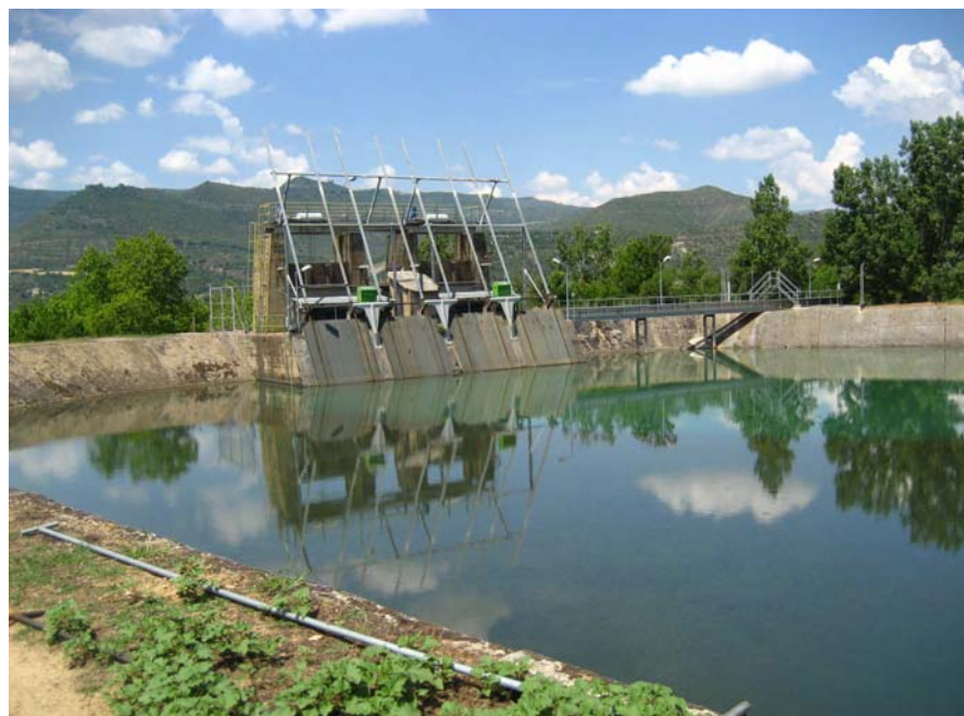
Figura 18.26: Resclosa del canal de Gavet, aigües avall de Tremp
