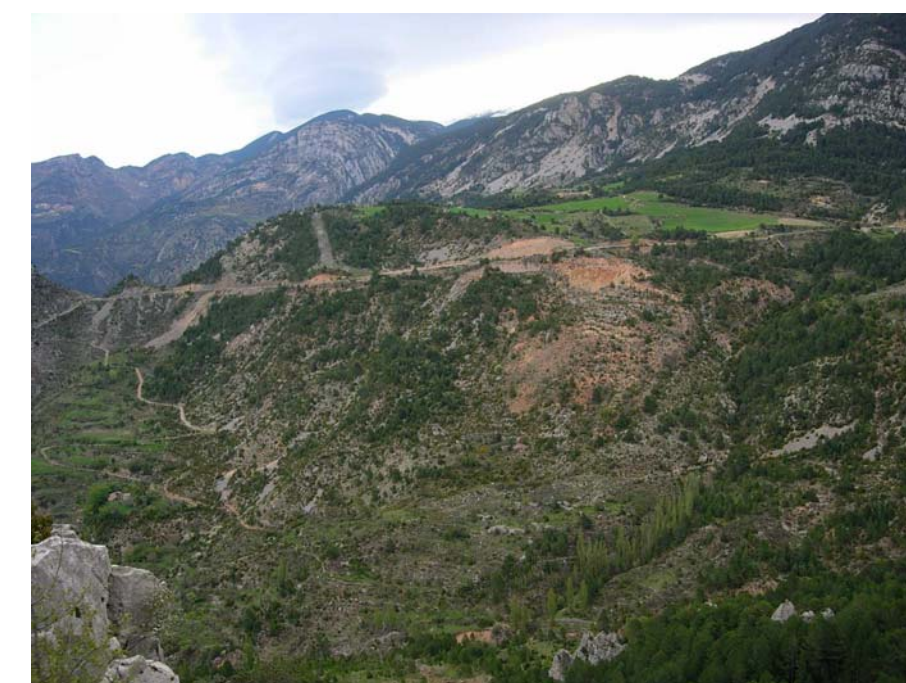
Figura 14.30: A la vall d'Alinyà, com en altres indrets de la unitat, hi ha terrenys inestables, tot i que no representen, per ara, un gran problema en la major part dels casos
