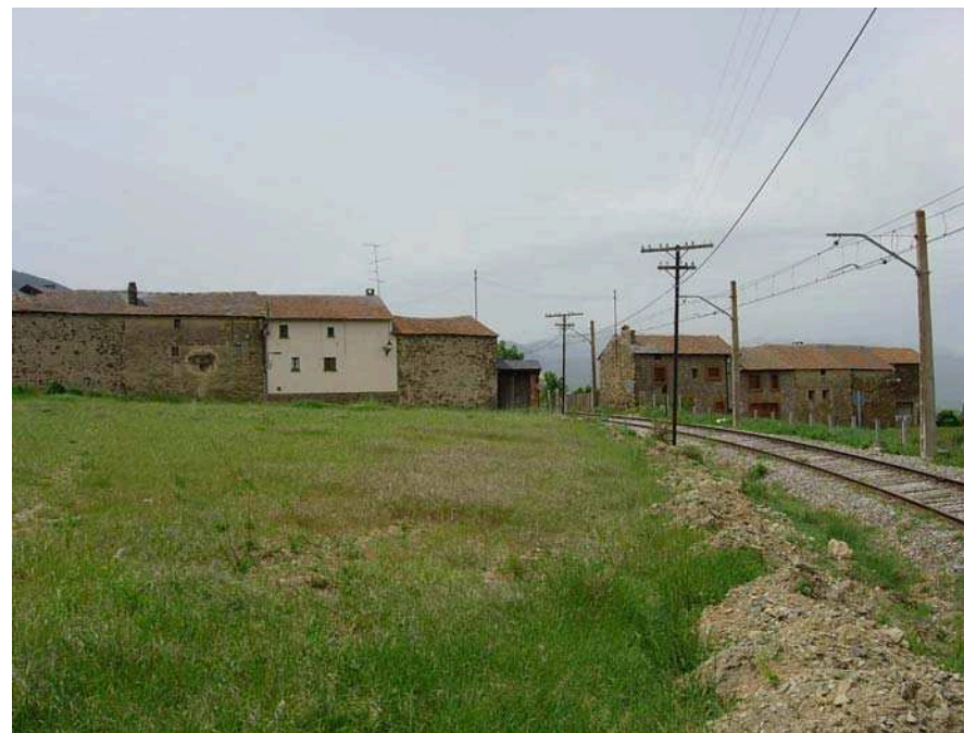
Figura 13.46: El traçat de la línia ferroviària de Puigcerdà a Barcelona presenta mancances tan flagrants, com aquesta al seu pas pel Vilar d'Urtx, que requereix actuacions imminents que poden canviar la vida i la fesomia d'alguns pobles
