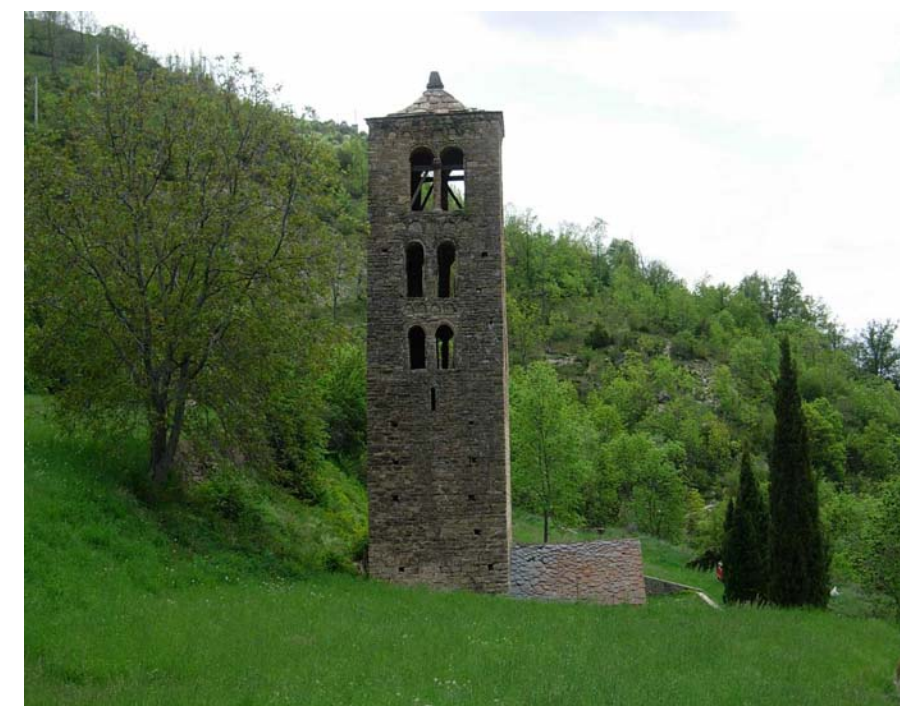
Figura 10.21: L'aïllat campanar de l'església de Sant Martí de Bescaran és un element arquitectònic d'interès històric i simbòlic indiscutible
