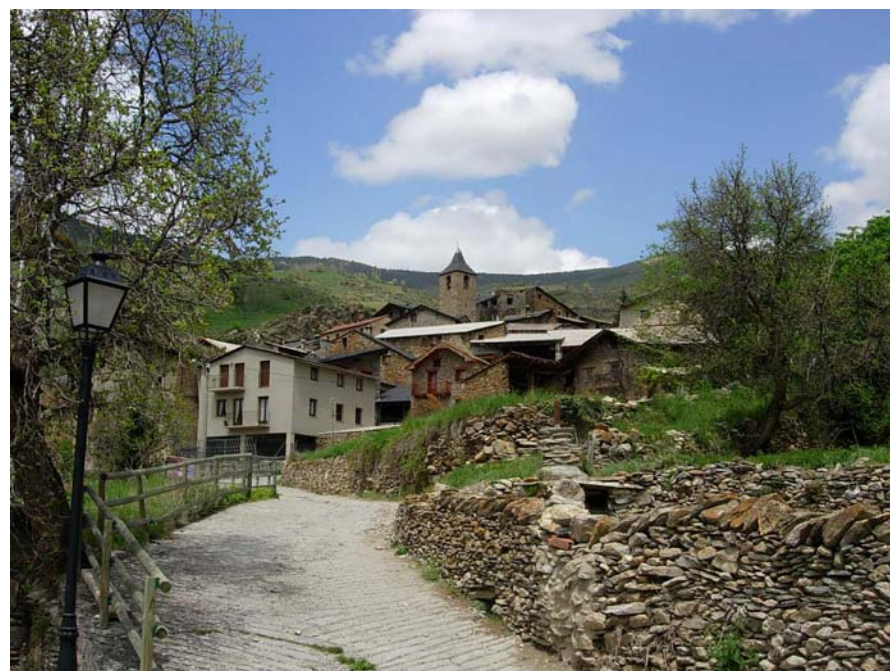
Figura 10.14: La pèrdua del patró que caracteritza els nuclis d'aquesta zona pels prats i les feixes que els envolten abans de donar pas al bosc és ben visible a pobles com Bescaran, on el pas del temps va deteriorant els murs de pedra seca tan característics del lloc
