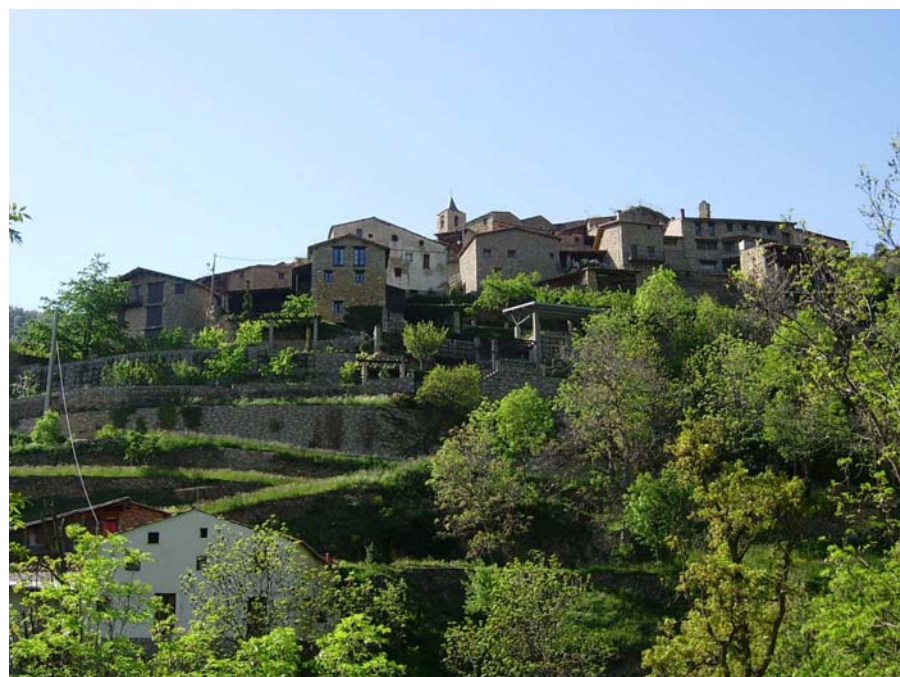
Figura 10.11: Les terrasses dels camps que envolten Castellnou de Carcolze, les espècies arbòries que encara perduren i alguns topònims de la zona són un testimoni de la varietat de conreus d'influència mediterrània que formaven part del paisatge agrícola d'aquest racó de la Solana del Baridà
