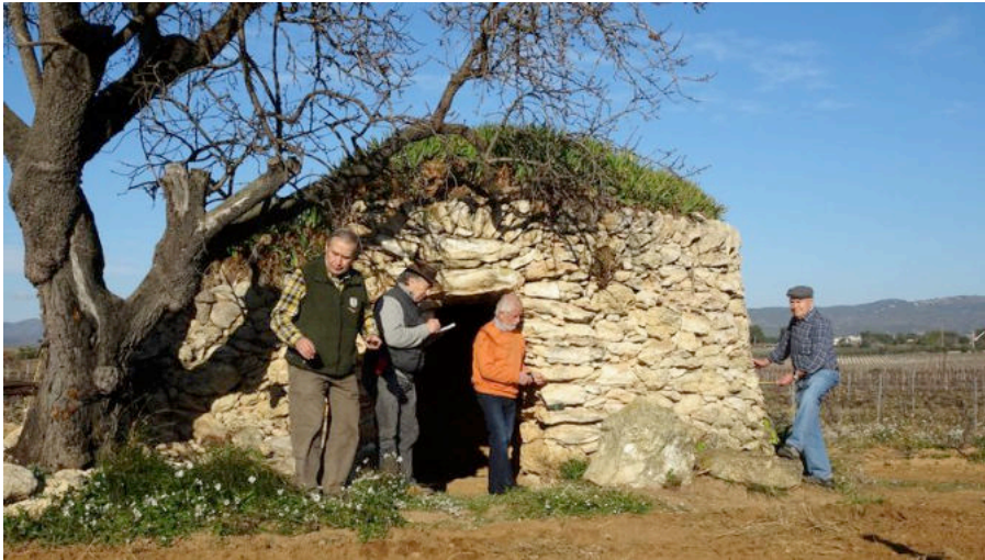
Una construcció de pedra seca al Garraf Grup Drac Verd de Sitges
