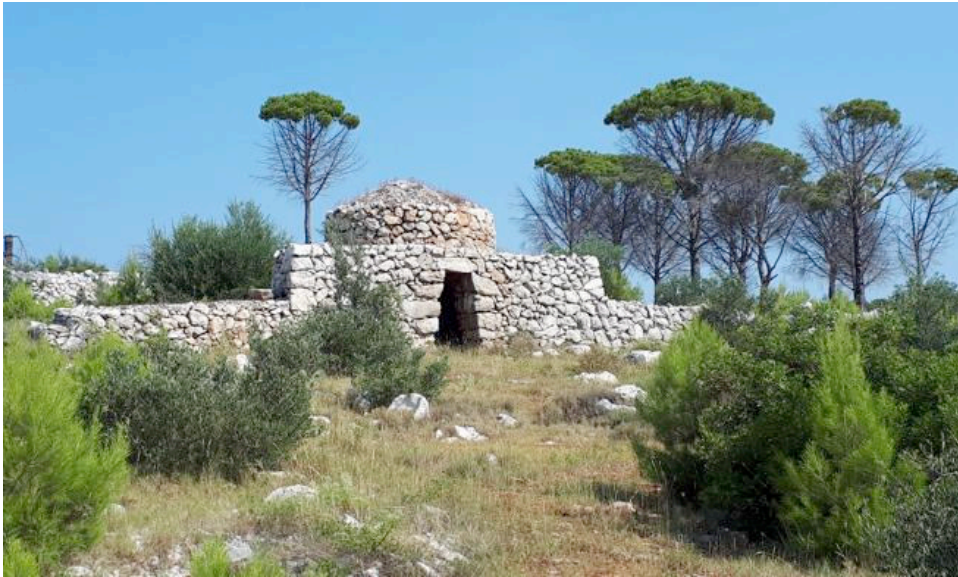
Barraca construida con la técnica de piedra seca (Cedida por Adrinoc)
