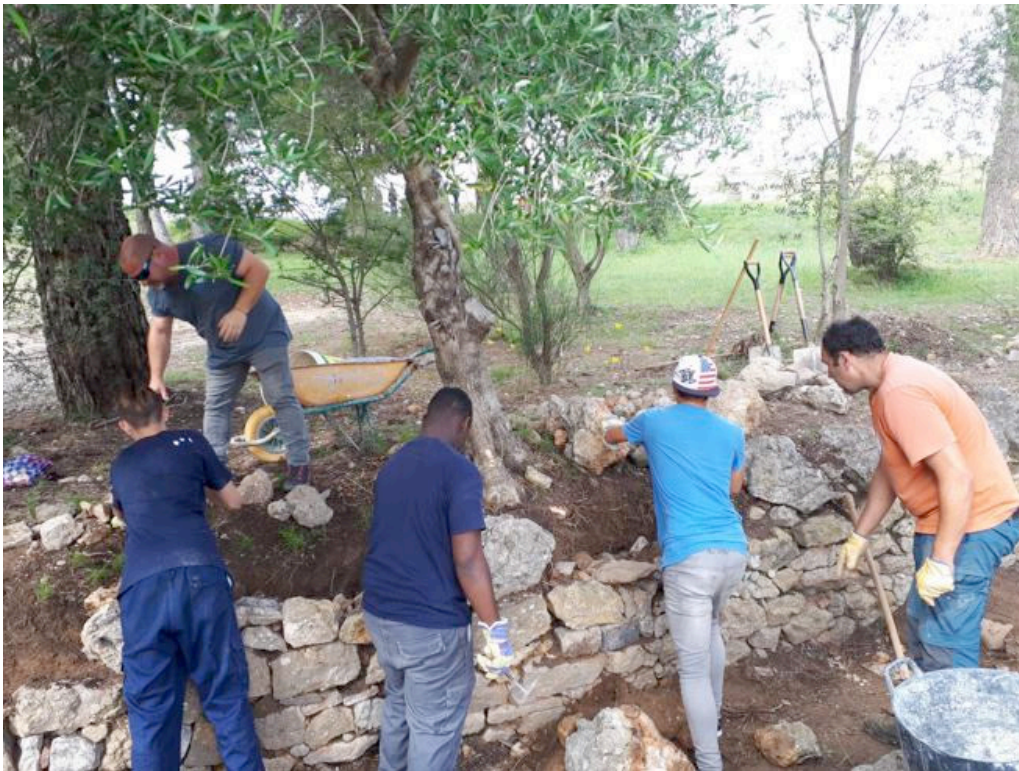
Taller de demostración sobre la construcción con piedra seca (Cedida por Adrinoc)
