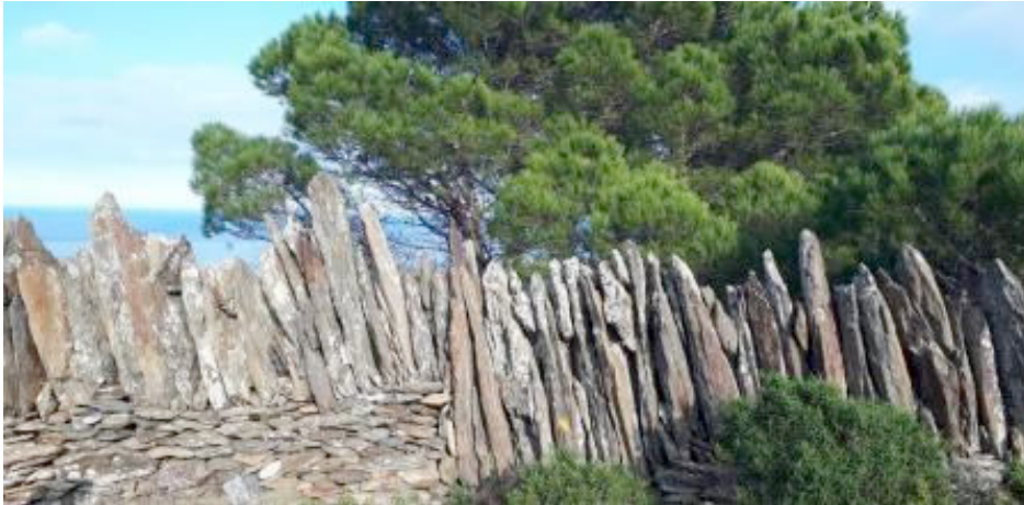
Muro construido con la técnica de la piedra seca (Cedida por Adrinoc)
