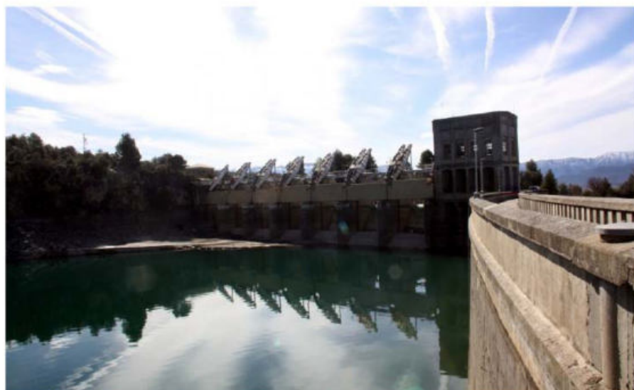
Presa de Sant Antoni, a Talam, amb les comportes de fons | ACN
