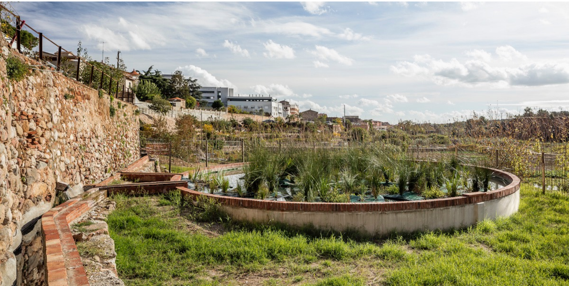
Rehabilitació del rec existent. Bassa de fitodepuració. Redistribució de l'aigua termal.
