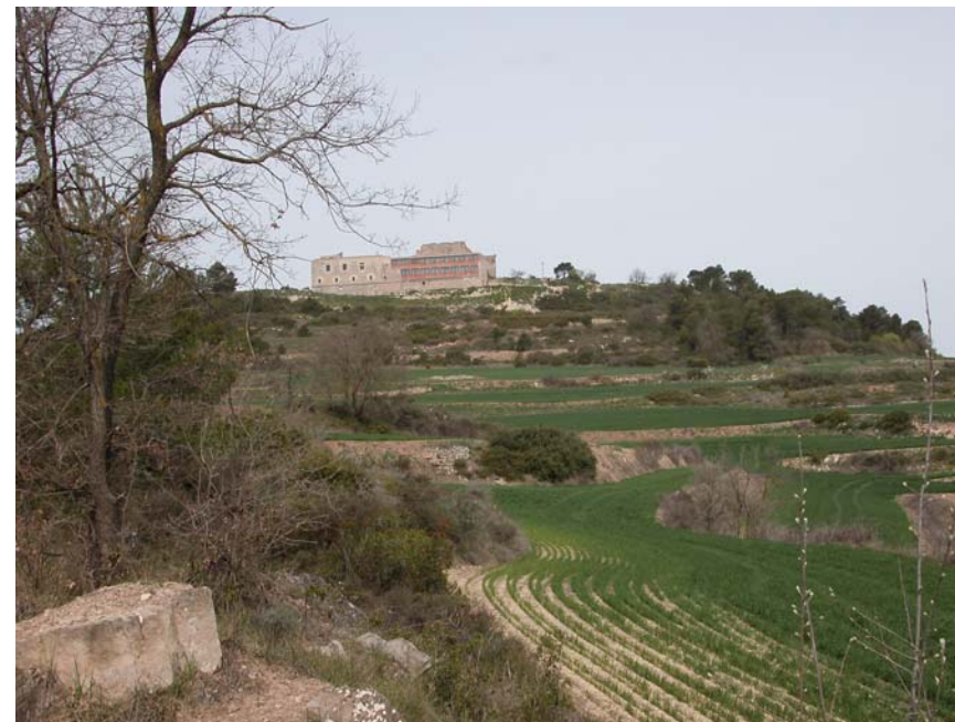
Figura 9.10. Santuari del Tallat, vista des del sud (03.04.2006).
