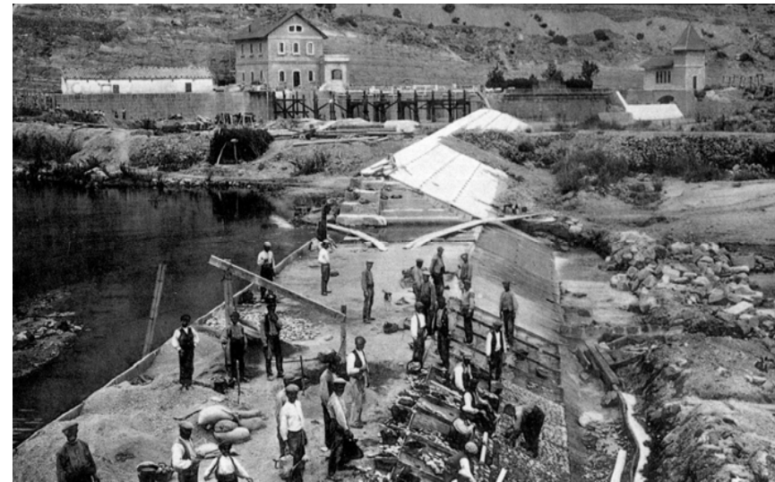
Figura 3.4. Imatge antiga de Ponts que mostra la construcció de la resclosa per derivar l'aigua al canal d'Urgell. Imatge cedida pel Servei d'Audiovisuals de la Fundació Pública Institut d'Estudis Ilerdencs de la Diputació de Lleida.
