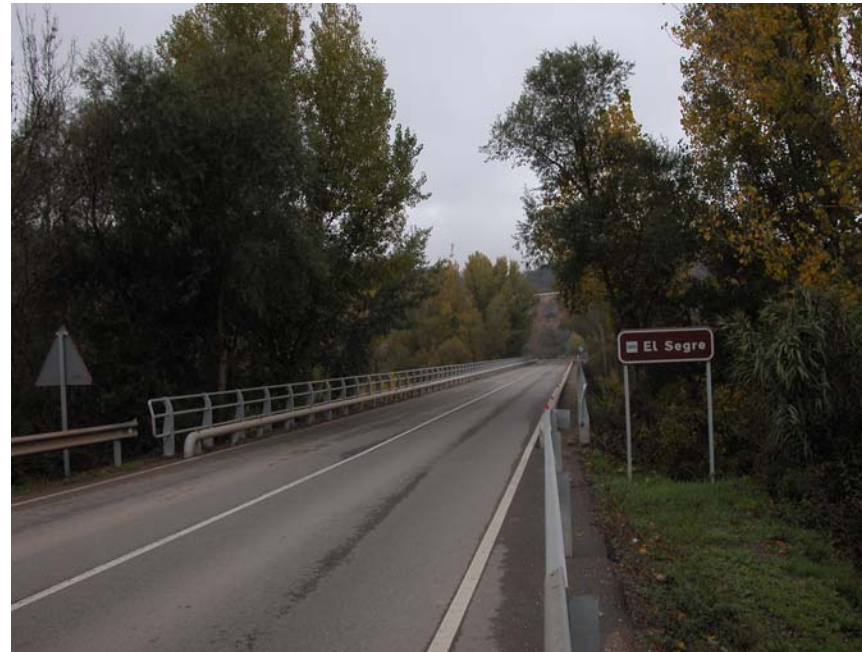
Figura 3.8. Pont de la carretera L-512 sobre el riu Segre, al Pont d'Alentorn (11.1.2005).
