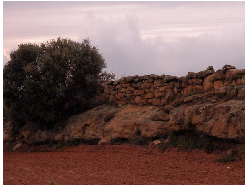
Figura 2.3. Aprofitament dels paleocanals per construir murs de pedra seca, no lluny de Guardiola (18.10.2005).
