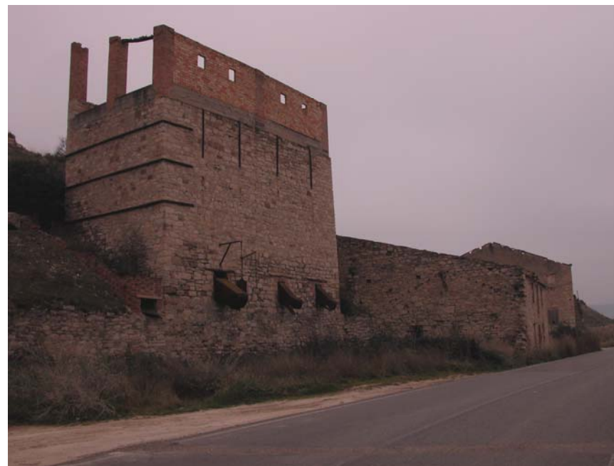
Figura 11.3. Antigues instal·lacions del nucli miner de la Granja d'Escarp, probablement una àrea de càrrega del lignit. Al peu de la carretera de la Granja d'Escarp a Mequinensa, no lluny del límit provincial (14.03.2006).
