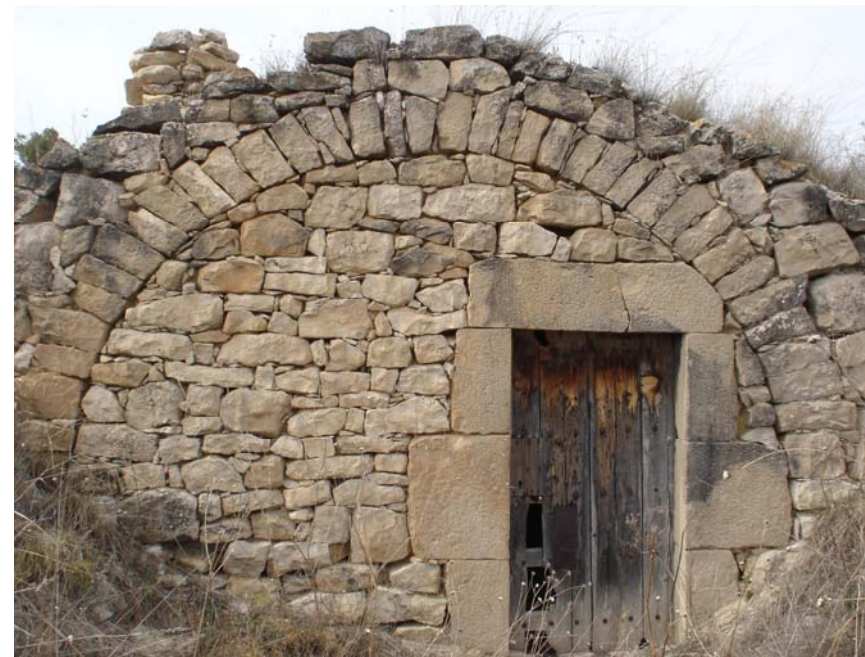
Figura 10.14. Detall de la forma de construcció d'una cabana de volta (foto: O. Cornudella)
