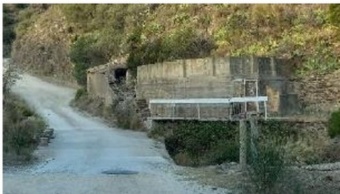
Caseta i dipòsit abandonats
