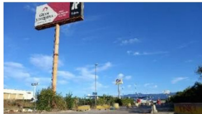
Polígon inacabat, amb materials i terres d'obra
