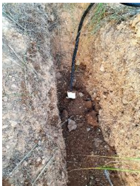
Figura 14 Imatges de la col·locació dels sensors
