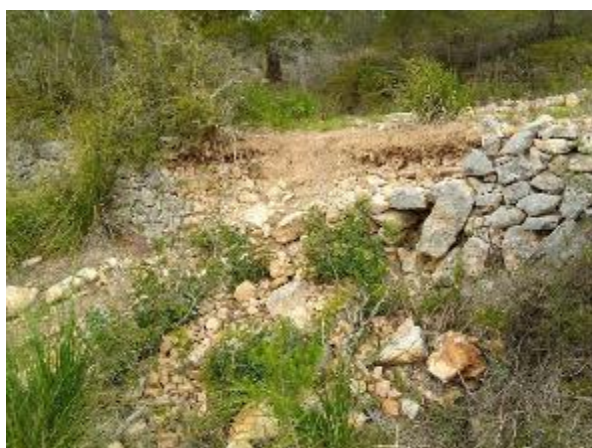
Figura 9 Marge de pedra seca. Ubicació 3
