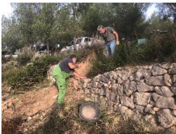
Figura 13 Imatges de la reconstrucció dels marges de pedra seca
