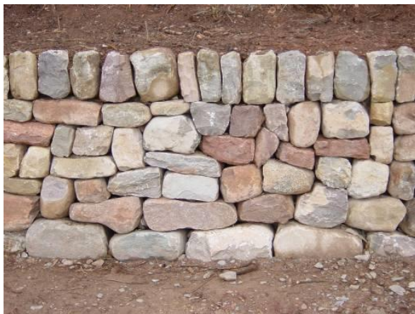
Figura 2: Marge estabilitzat amb un mur de pedra seca
