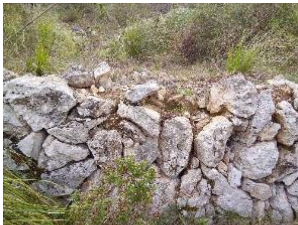
Figura 7 Marge de pedra seca. Ubicació 1
