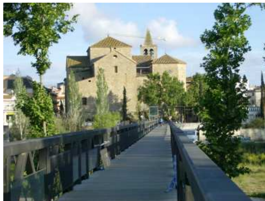
Figura 8.13: El pont de ferro de Tordera.
