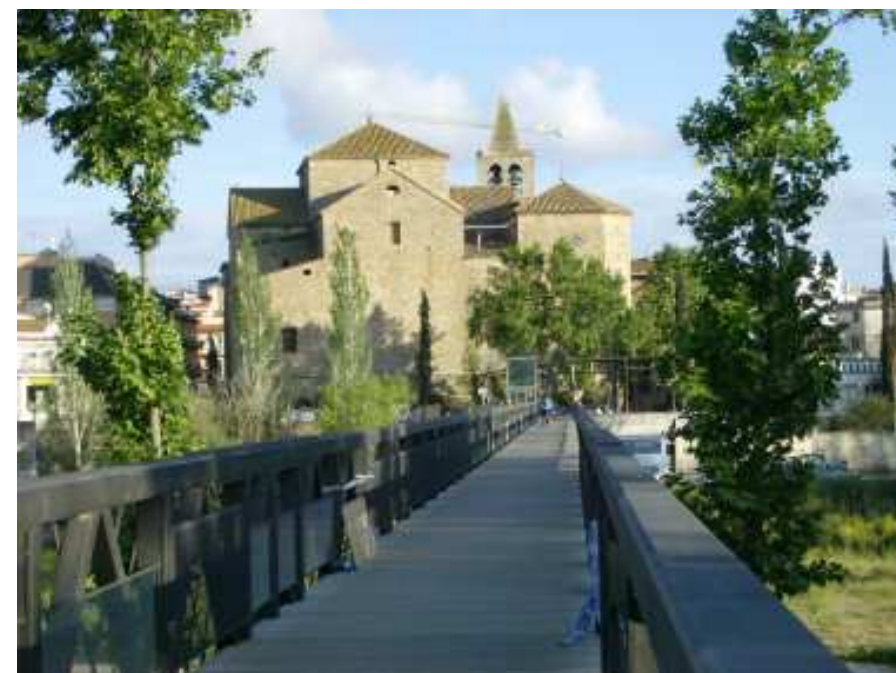
Figura 8.13: El pont de ferro de Tordera.
