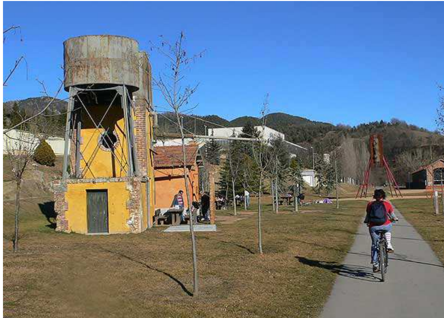
Figura 4.13: Antigues instal·lacions de les mines de carbó d'Ogassa.
