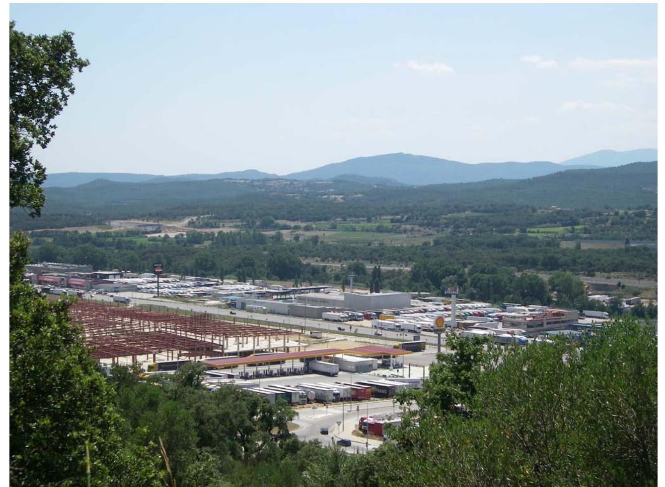
Figura 3.3: Instal·lacions per al transport internacional de mercaderies a La Jonquera.
