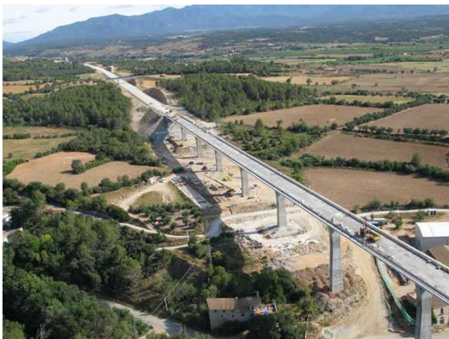
Figura 3.22: Construcció del TAV a Pont de Molins.
