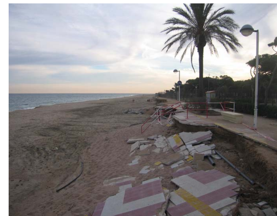
Figura 2.22: La platja de S'Abanell, a Blanes, està molt afectada per problemes d'erosió.
