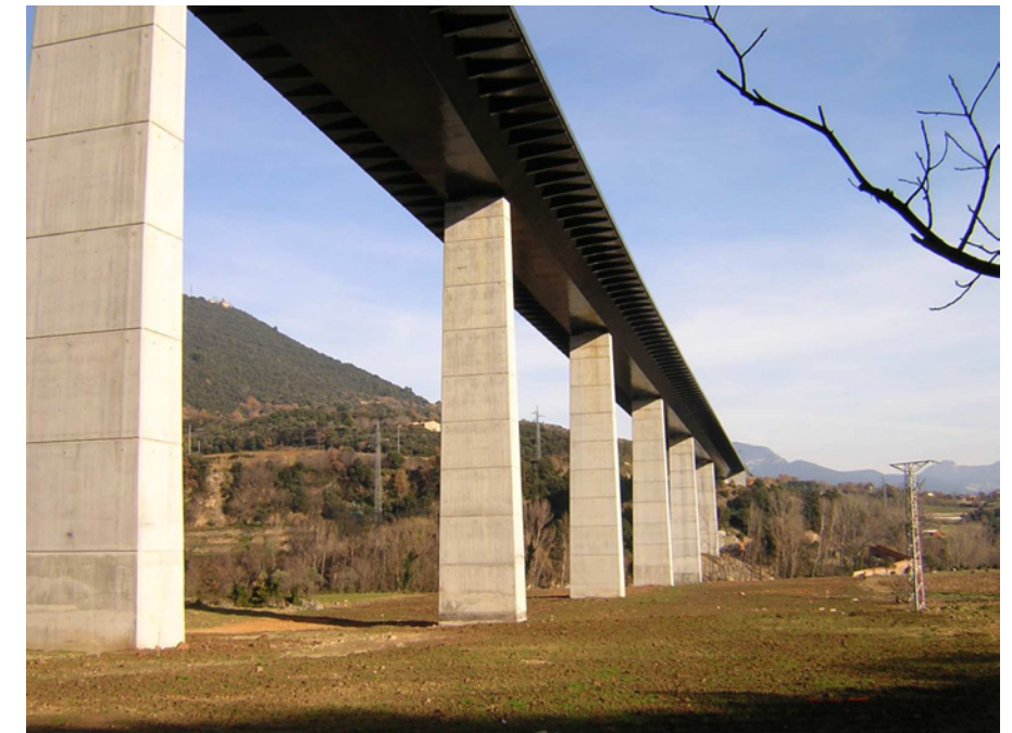
Figura 23.38: Viaducte de Castellfolit de la Roca.
