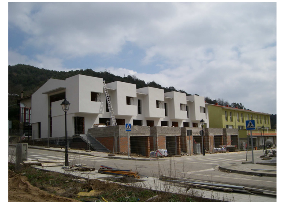
Figura 23.35: Construcció d'una promoció de cases unifamiliars a Sant Feliu de Pallerols.
