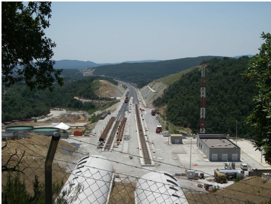
Figura 20.22: Obres de construcció del TAV.
