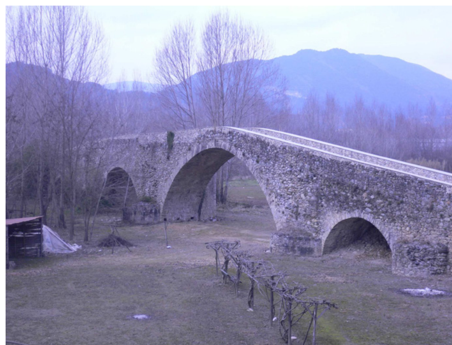
Figura 19.12: El pont romànic de Sant Julià del Llor edificat sobre un tram del llit del Ter que actualment no és funcional.
