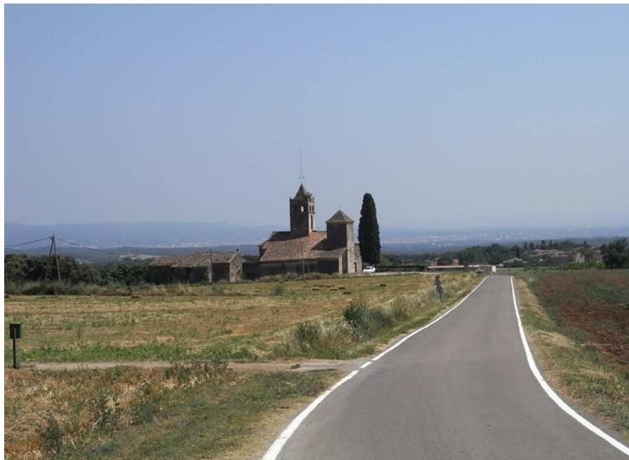
Figura 19.21: La carretera GIV-5313 travessa paratges excepcionals dels plans de Canet d'Adri.
