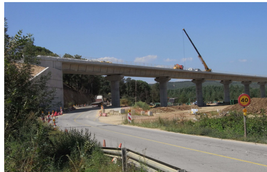
Figura 18.22: Construcció d'un viaducte per al TAV prop de Massanes.
