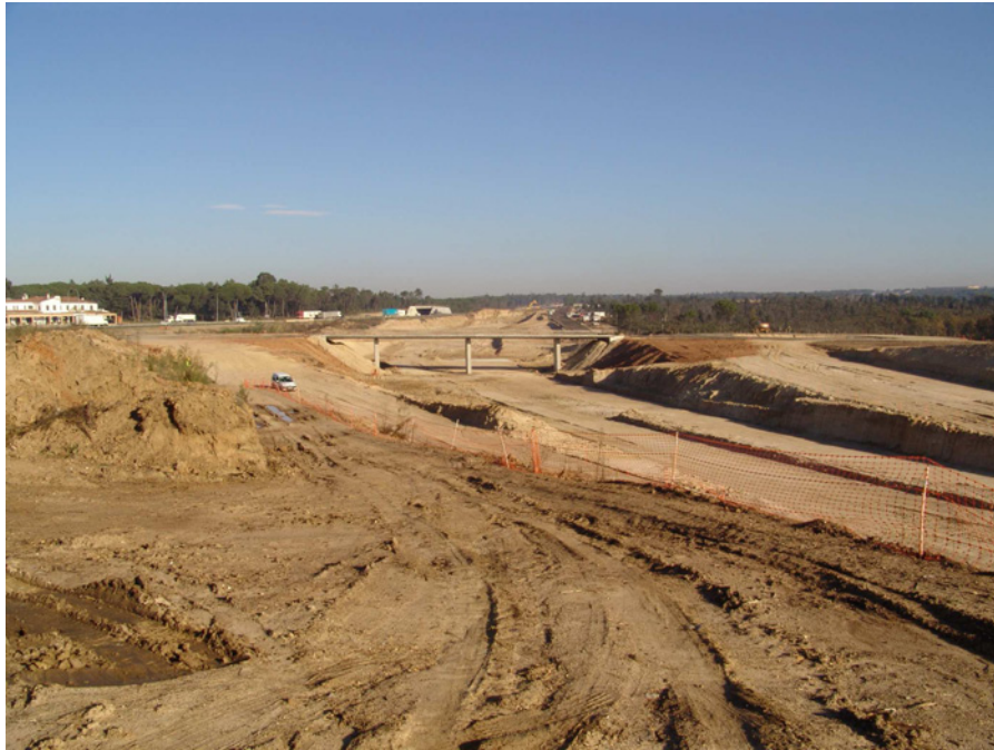
Figura 18.24: Obres de construcció de l'autovia A-2.
