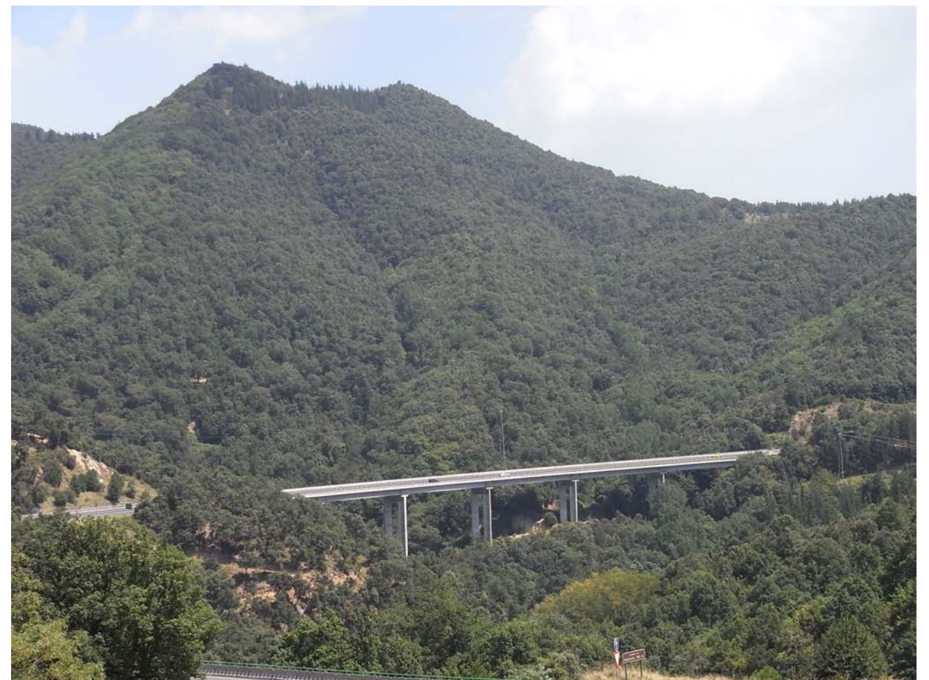
Figura 13.5: L'Eix Transversal travessa les Guilleries d'est a oest.
