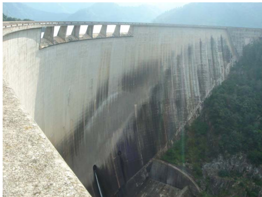
Figura 13.25: Imatge de la presa de l'embassament de Susqueda.
