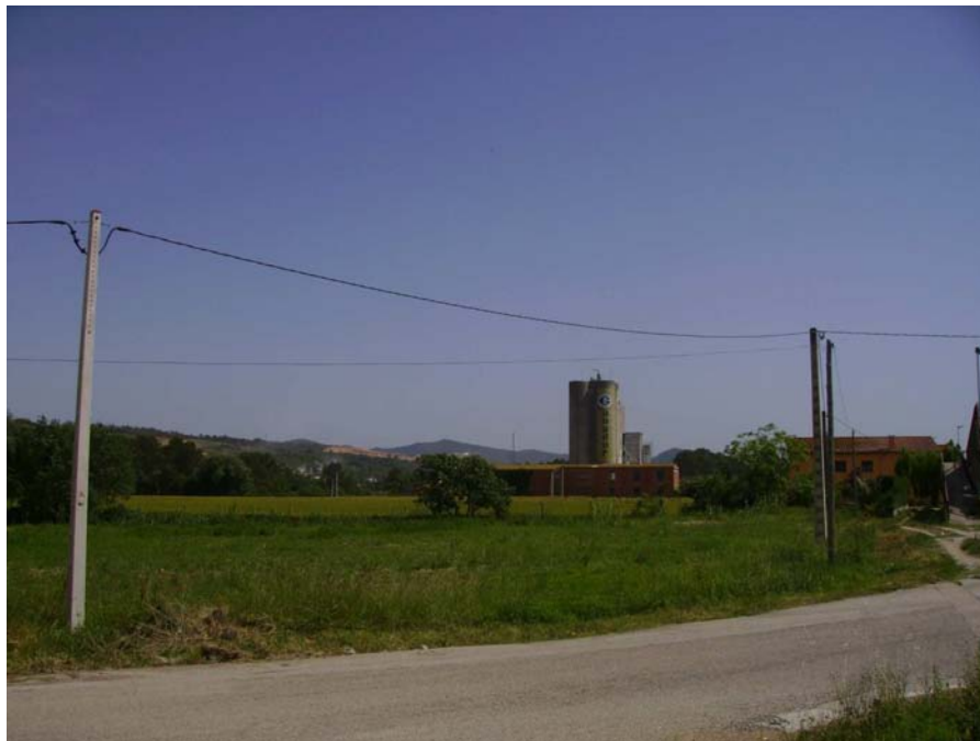
Figura 10.27: Edificacions en sòl no urbanitzable a les proximitats de la carretera C-66.
