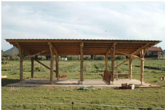
Imatges 3 i 4. Treballs de construcció del cobert per a Can Mercaderet, on es van seguir els processos tradicionals. Fotos: Gabor Bouman.
