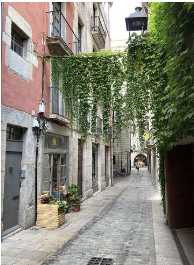
Imatge 1. La polèmica instal·lació del cablejat de fibra òptica en façana, en aquest cas objecte d'una particular i espontània intervenció d'integració, en un carrer de Girona. Foto: Narcís Sastre Fulcarà.
