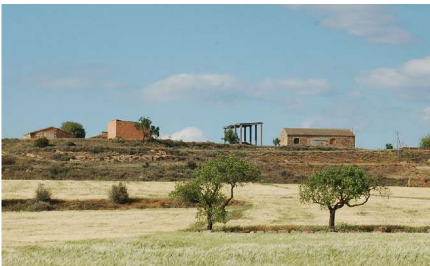
Imatge 4. Com a criteri bàsic, a l'espai obert pel seu caràcter àmpliament perceptible, cal compactar les construccions, tot demolint els elements obsolets. Foto: Departament de Territori, Habitatge i Transició Ecològica de la Generalitat de Catalunya.
